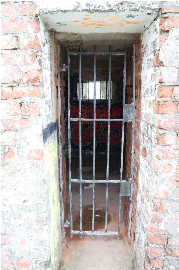
Entrance way grille, IMG_9769, 03.03.2016
